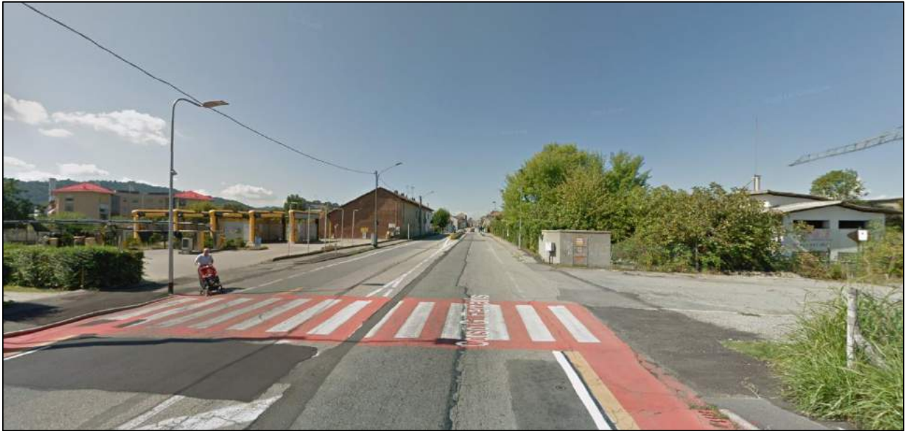
Corso Galileo Ferraris – Area di intervento – Vista in ingresso a Chivasso
